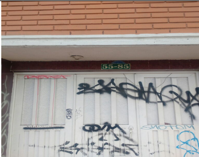
FOTOGRAFIA 2: Vista de la nomenclatura del inmueble de la AUTOPISTA SUR No 55-83 / hoy 55- 85 (Dirección actual), en donde no se encuentra instalado el elemento de Publicidad Exterior Visual, objeto de traslado.
